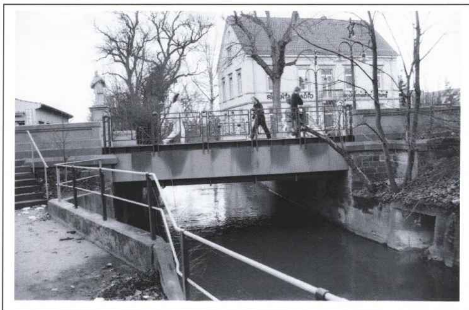
Ehemalige Kraichbachbrücke in der Karlsruher Straße
